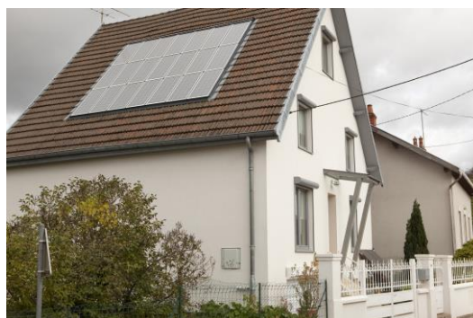
Photo d'illustration d'une rénovation avec installation de panneaux photovoltaïques
