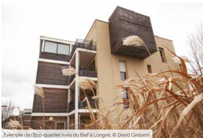
Exemple de l'Eco-quartier rives du Bief à Longvic © David Cesbron
