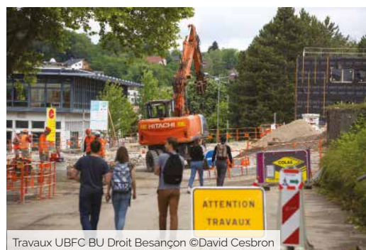
Travaux UBFC BU Droit Besançon ©David Cesbron
