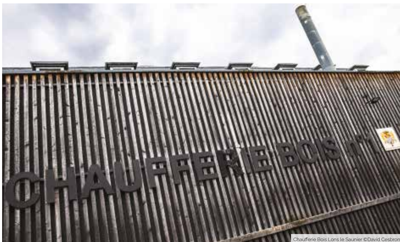
Chaufferie Bois Lons Le Saunier ©David Cesbron
