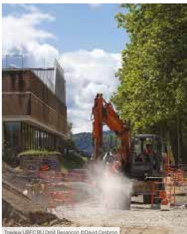
Travaux UBFC BU Droit Besançon ©David Cesbron
