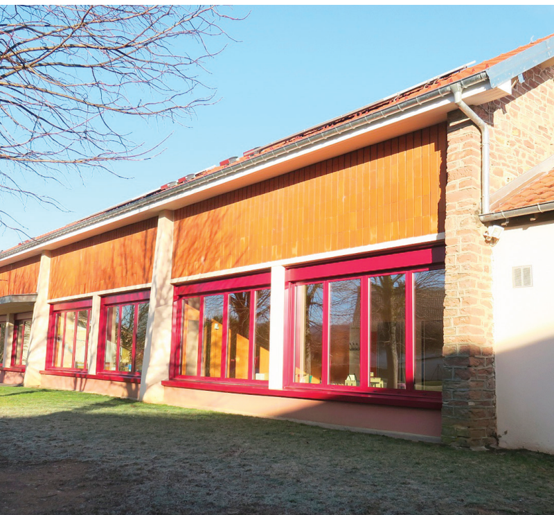
Commune de Champagny (70) Restructuration de l'école maternelle Maître d'œuvre : Itinéraires architecture (90)
