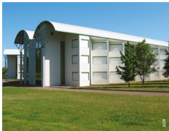
L'antenne du lycée agricole de Challuy.
