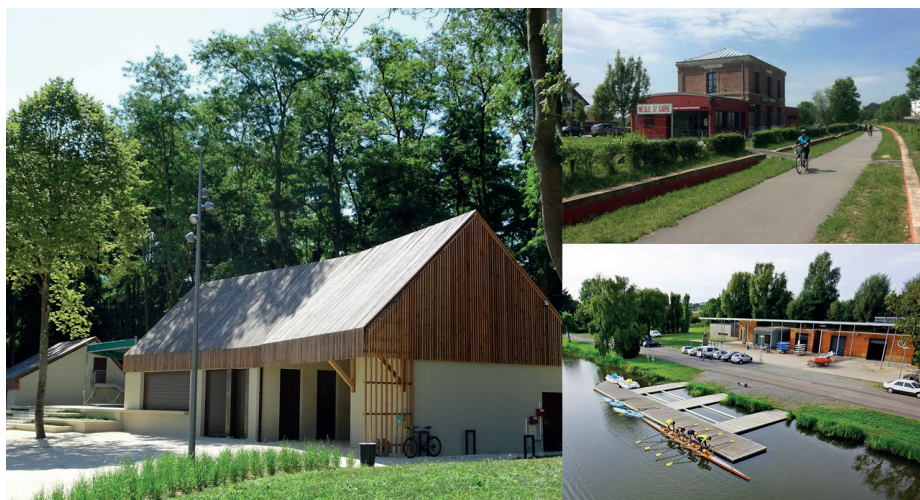
©Admire Architecture - Exemples d'aires de services : le « Relais des berges » à Azay-sur-Cher [37], le « Quai gourmand » à Nesle-Hodeng [76], et le « Quai vert » à Frossay [44]
